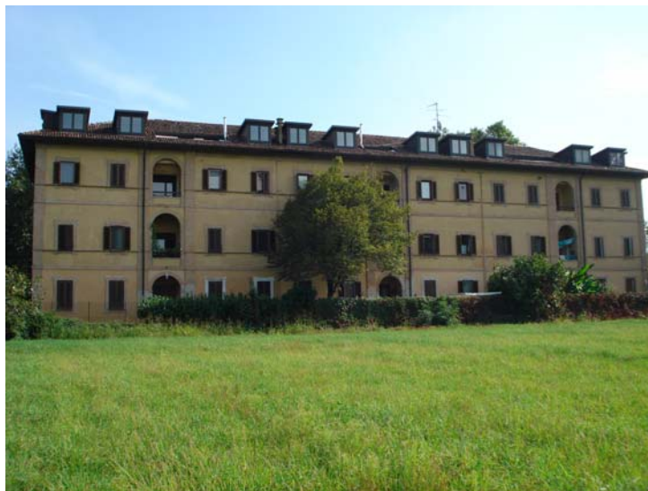
Foto- vista ovest – stato di fatto edificio 3
