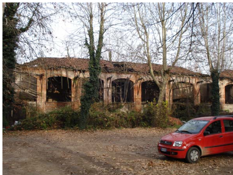
Foto- vista interna cortile – stato di fatto edificio 1 – ex stalla fienile
