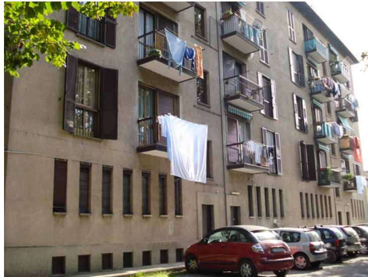
Foto- vista ovest – stato di fatto edificio 4
